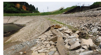
大切畑ため池における法面圧縮崩壊の様子
