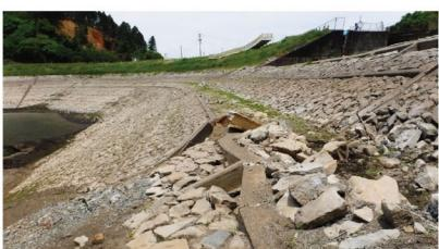
平成28年(2016年)熊本地震で、震度7を観測した熊本県西原村の大切畠ため池では、農地への送水管が破断して水が流出し、下流の集落に避難指示が発令されました。なお、緊急放水で水位を下げることで決壊を免れています。
