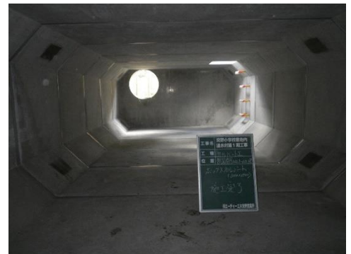
雨水貯留槽の内部
