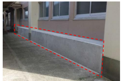
構造体の補強による対策後
