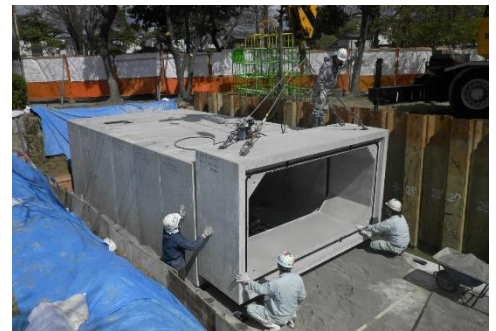
校庭の地下への雨水貯留槽の設置
