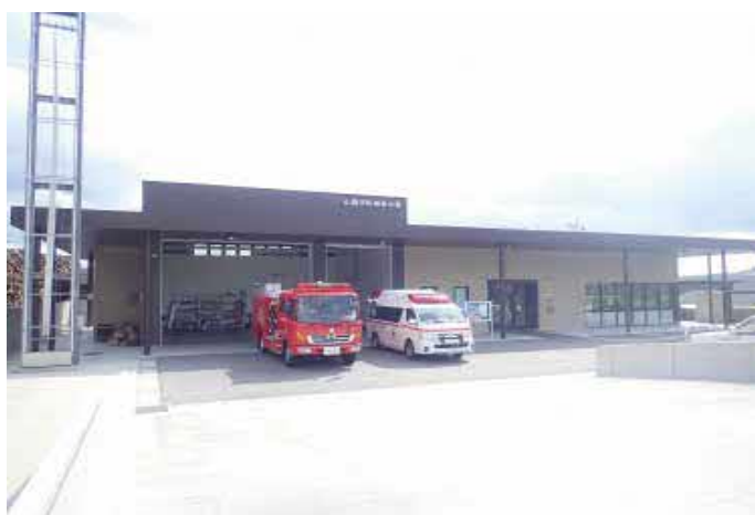
配置予定先の東分署（鹿本町津袋）：管轄は菊鹿・鹿本地域
