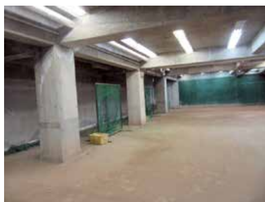
市民球場の改修（山鹿市民球場長寿命化対策事業）
