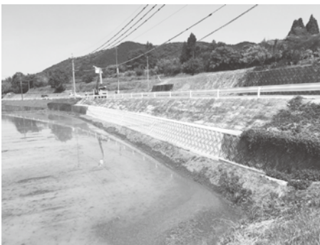
市道大河内線復旧後
