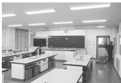
天井に 空調が設置された 特別教室
