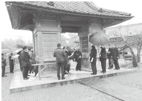
工事が完了した少彦名神社楼門
