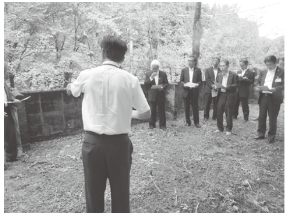
旧岳間小学校ブロック塀
