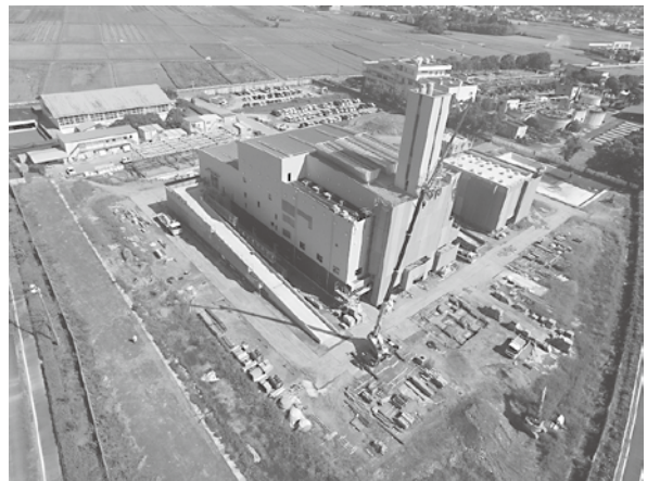
建設が進む山鹿市環境センター全景
