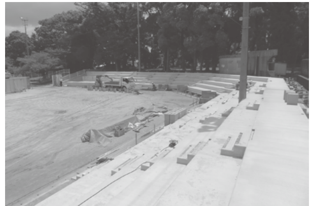
山鹿小学校屋外運動場既設スタンド改修工事（6/12）
