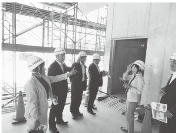
一般廃棄物処理施設建築現場
