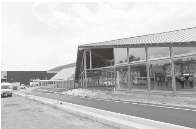
菊鹿ワイナリー建築工事現場
