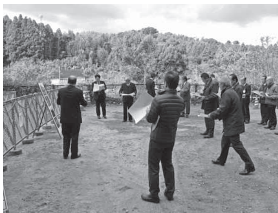
上久野A団地汚水処理施設工事現場
