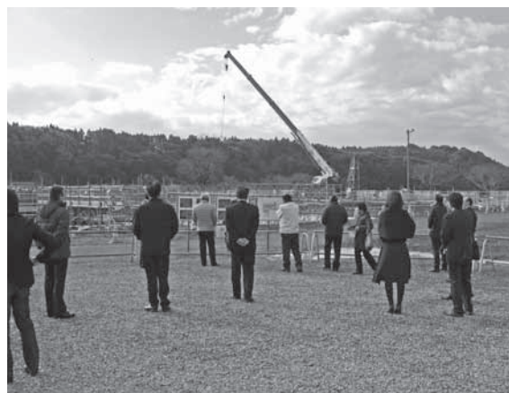
廃棄物処理施設建設工事現場（石地区）
