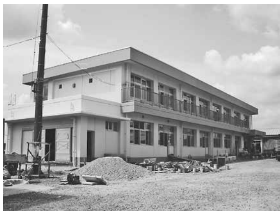
統合校増築工事（めのだけ小学校）
