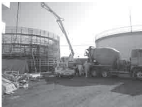
方保田配水地
