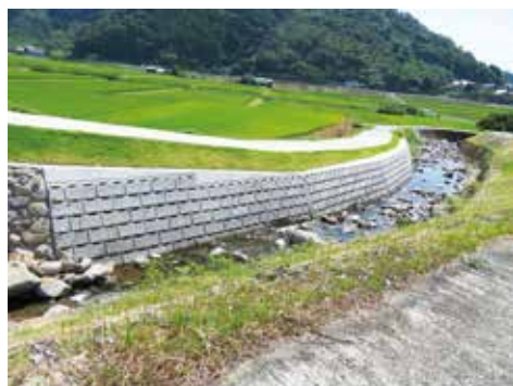
矢谷地区瀬野川復旧後
