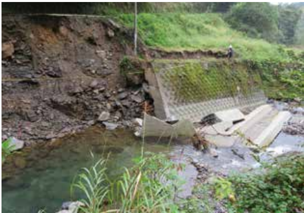
後川内地区の護岸と農道決壊
