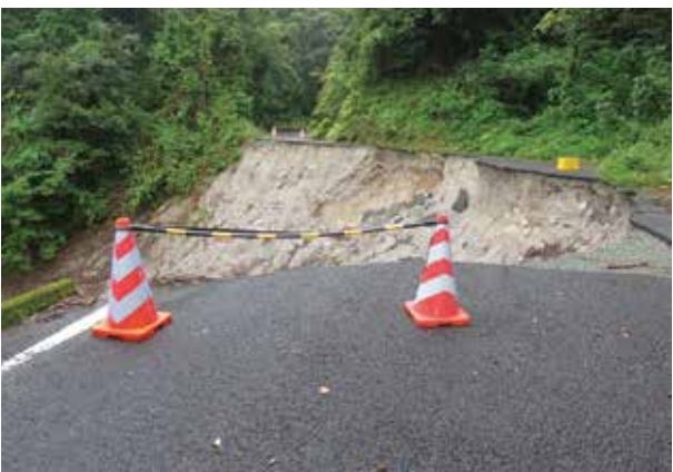
林道八方ヶ岳西線災害
