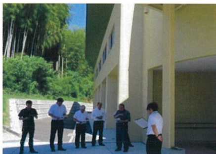
R6. 9. 13 八幡小学校体育館
