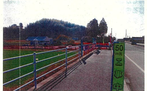
「歩道の工事」菊鹿町電口橋<4月20日>
