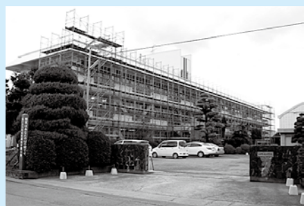
校舎の耐震補強工事
