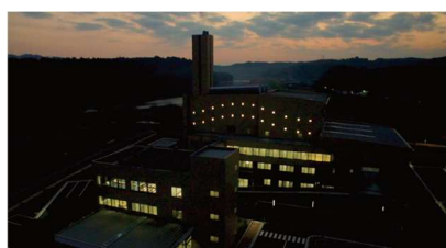
夜間の山鹿市環境センター
