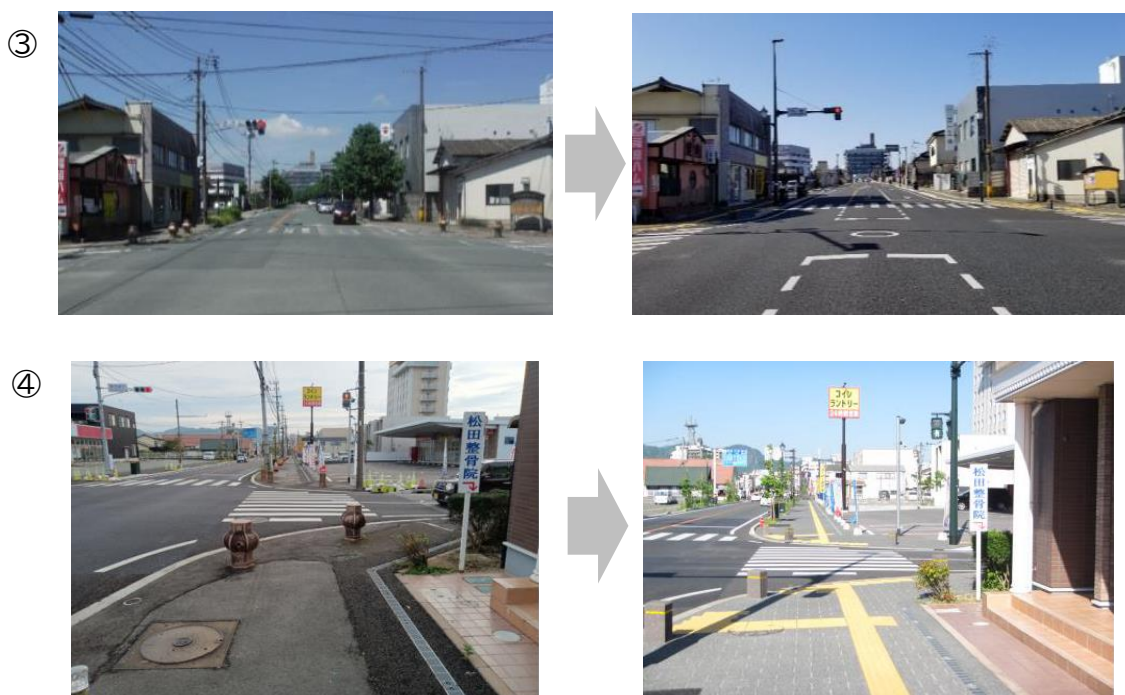
写真 2-5 県による無電柱化の実施状況
