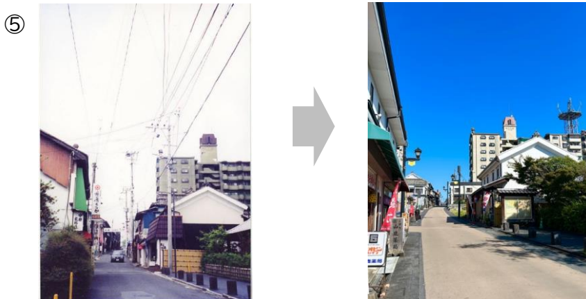
写真 2-6 市による無電柱化の実施状況
