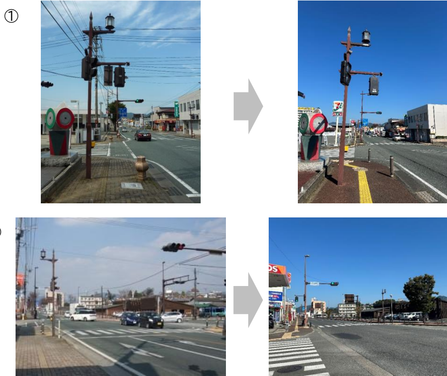
写真 2-4 国による無電柱化の実施状況
