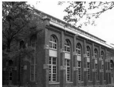
熊本大学工学部研究資料館（旧機械工場）
