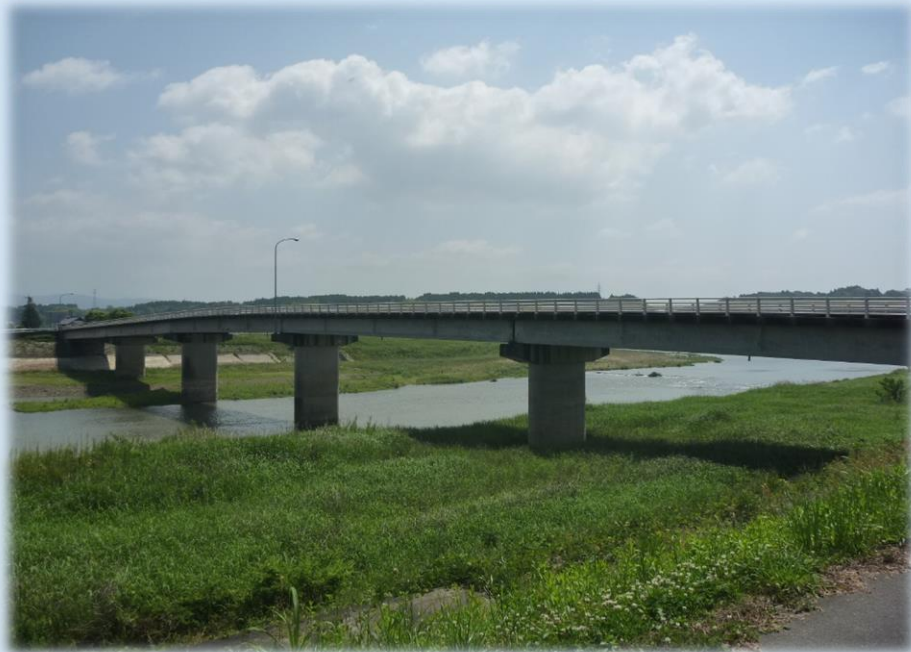
山鹿西部大橋
