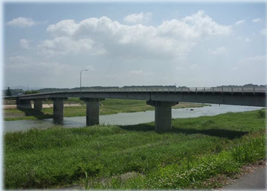
山鹿西部大橋
