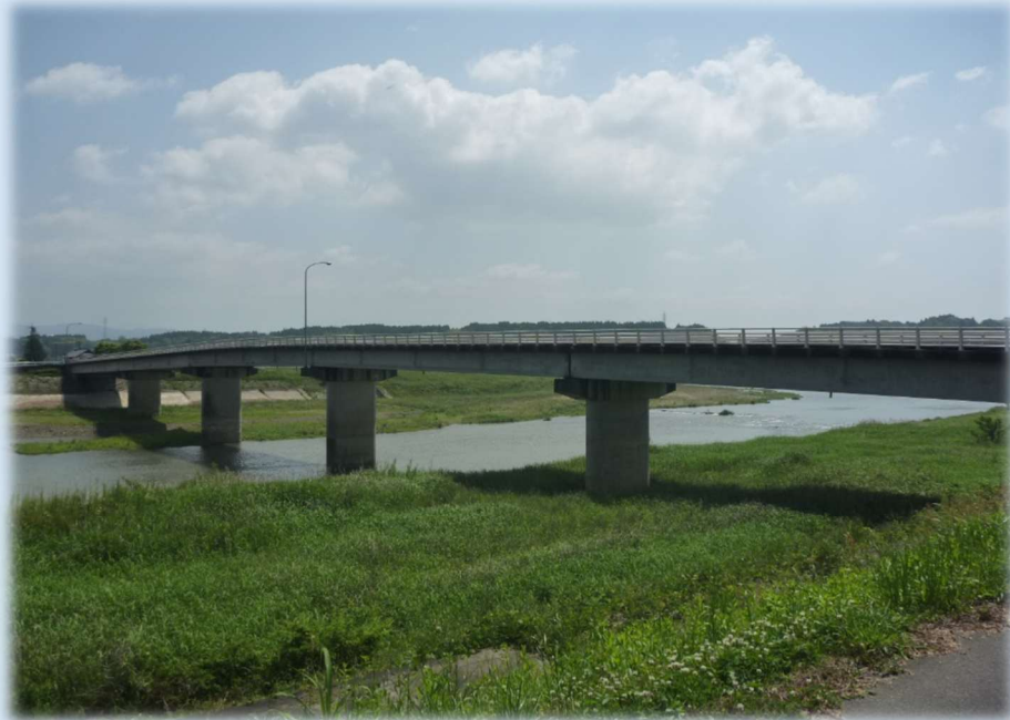
山鹿西部大橋
