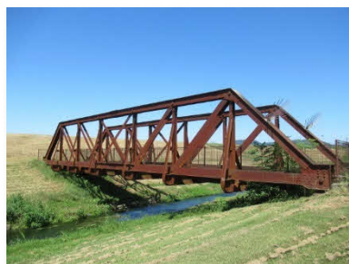
鹿本鉄道鉄橋
