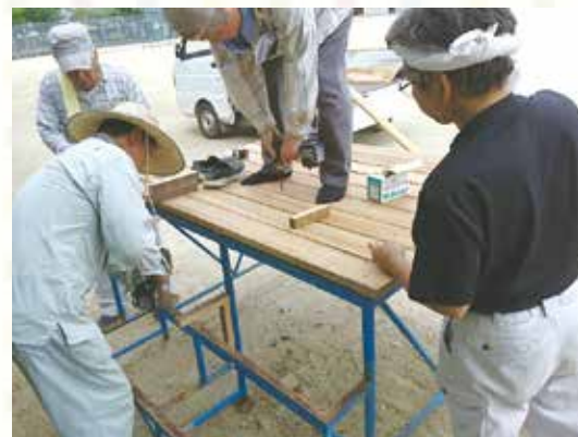
指令台の補強作業の様子
