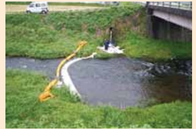
《環境保全対策事業》 油漏れ対策
