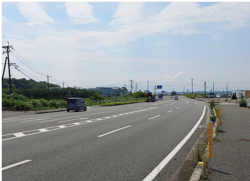
国道325号の4車線化
