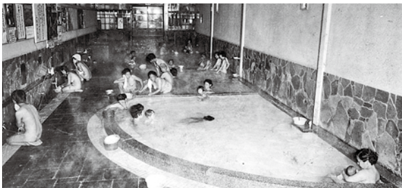
昭和 33 年改修以後の桜湯浴室
