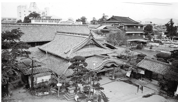
昭和 48 年解体直前のさくら湯（南側）
