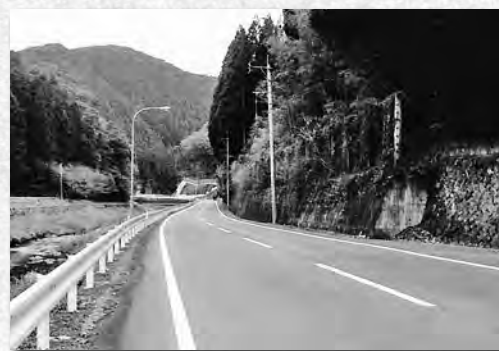
現在では当時より大幅に拡幅されています
