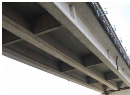
コンクリート橋
