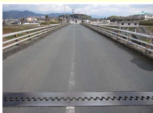
一般橋梁の注目する部材（路面、伸縮装置等）
