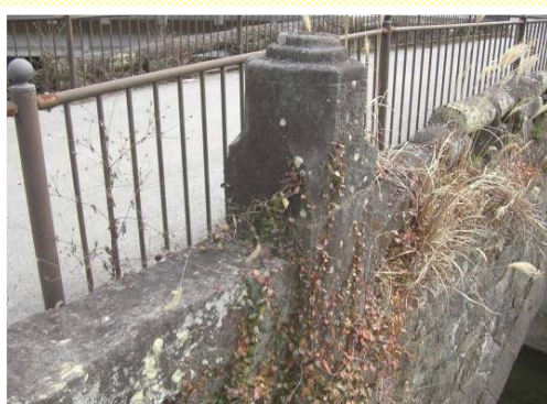
石橋の注目する部材（路面、高欄等）
