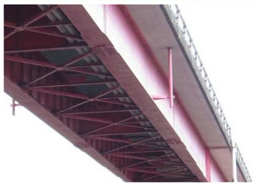
一般橋梁の注目する部材（主桁、床版等）
