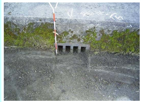
橋面の清掃：清掃後
