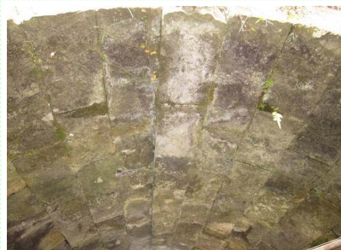
石橋の注目する部材（輪石等）
