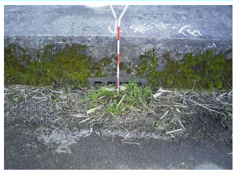
橋面の清掃：清掃前
