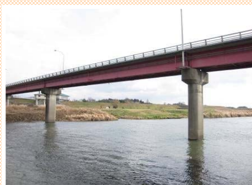
一般橋梁の注目する部材（橋台、橋脚、支承等）
