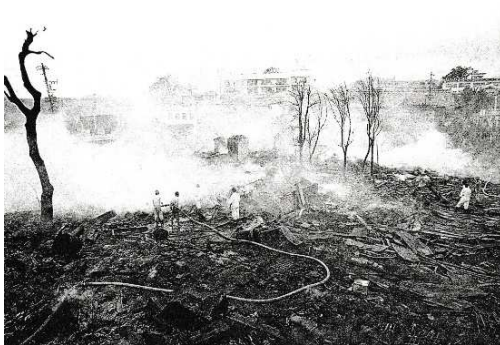
写真4-1 昭和46年大火災後の状況
