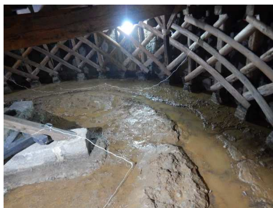
写真 4 - 30 奈落湧水状況 (2)
