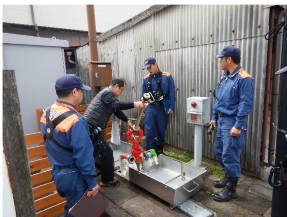
写真 4 - 6 放水銃の点検
