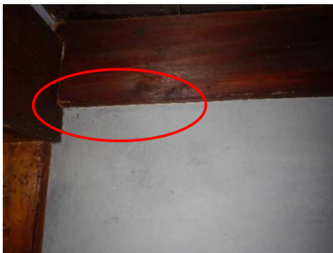
写真 4 - 25 内部漆喰壁チリ際のヒビ
