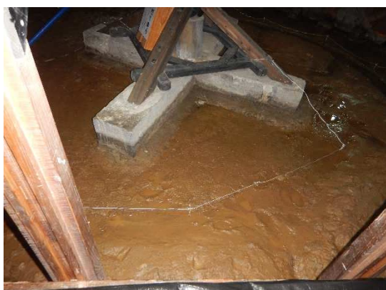
写真 4 - 31 奈落湧水状況 (3)
