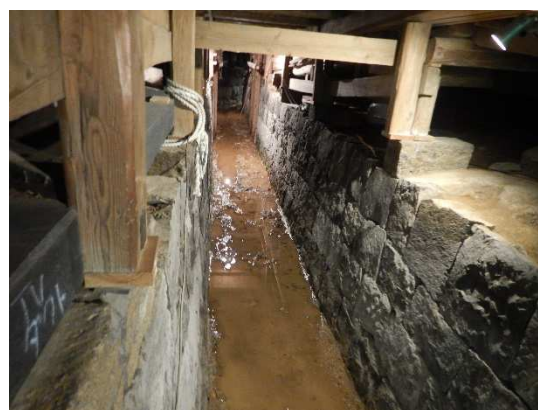
写真 4 - 32 奈落湧水状況 (4)
