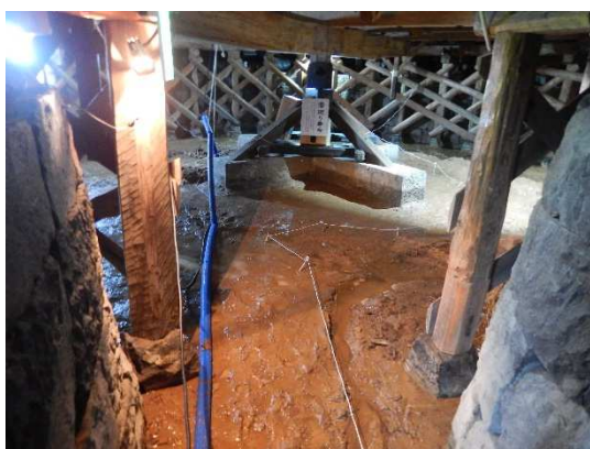
写真 4 - 29 奈落湧水状況 (1)
