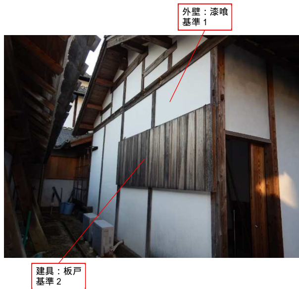
南面外観 (仕出シ場)
