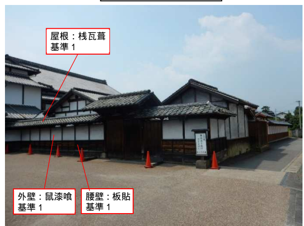
附指定：土塀（本屋東方）
