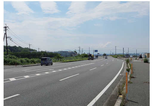
国道325号の4車線化
