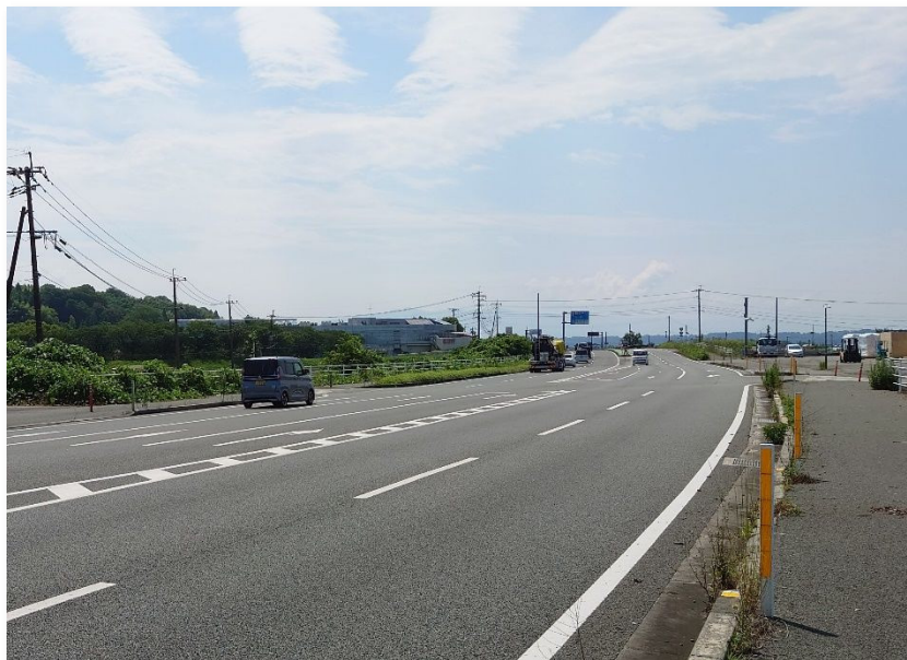
国道325号の4車線化
