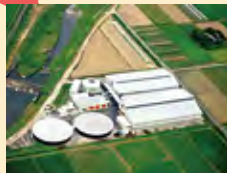
バイオマスセンター
