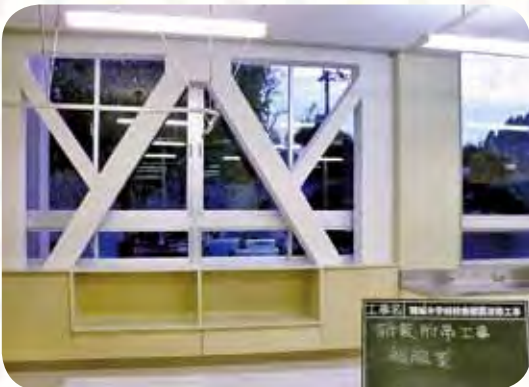
鶴城中学校校舎耐震改修工事
