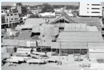
▲さくら湯の整備を進めています。
