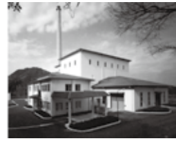
燃やすごみ処理施設 クリーンセンター
