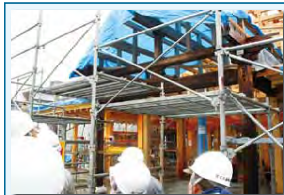
南側玄関の様子
