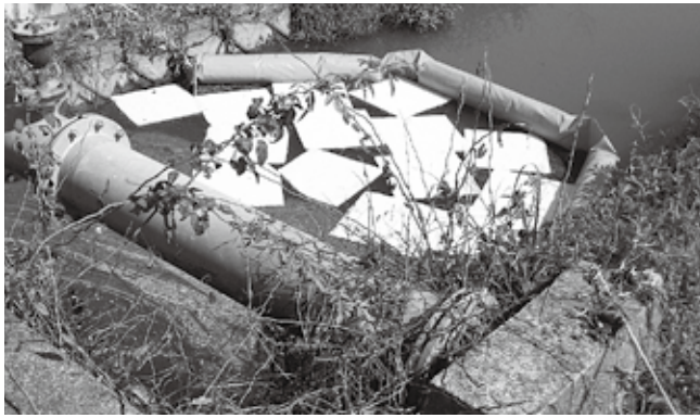
本流への油流出を防ぐため、オイルフェンスとオイル吸着マットを設置した様子
