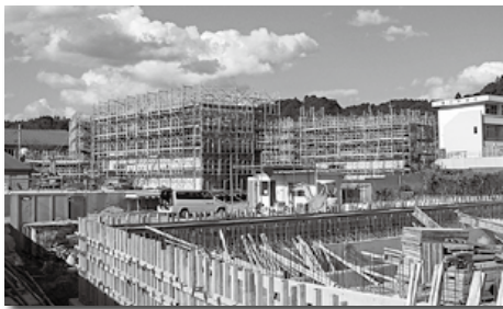
▲鹿北小学校の校舎の整備を進めています。
