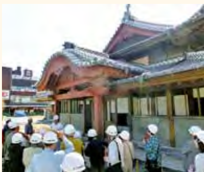
北側玄関の様子
