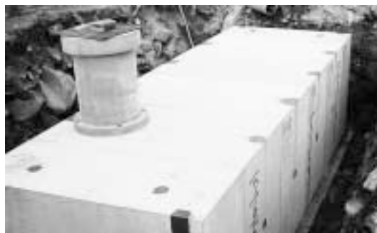
◀ 防火水槽の建設（消防施設整備事業）
