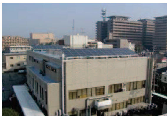
太陽光発電（上下水道局別館）
