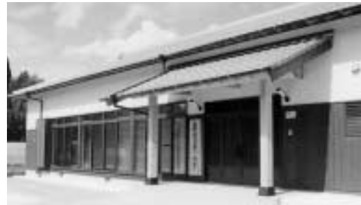
▲完成した東野コミュニティセンター（鹿北地区）
