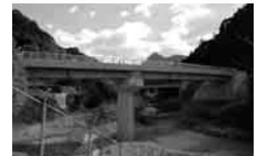
市道番所山田線(番所橋)の開通で利便性が向上
