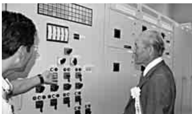
▲職員の説明を聞きながら鹿本中継ポンプ場を視察する宮崎さん
