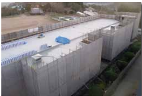
菊鹿統合小学校の工事状況
