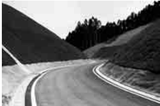
利便性の向上を図るため、整備が進む市道星原線
