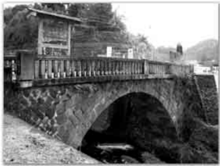
▲田中橋 (下流より)
