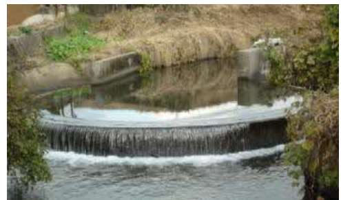
写真 御宇田井手の円形分水工
