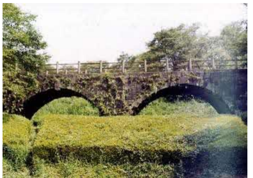
写真 移築復元された湯町橋
