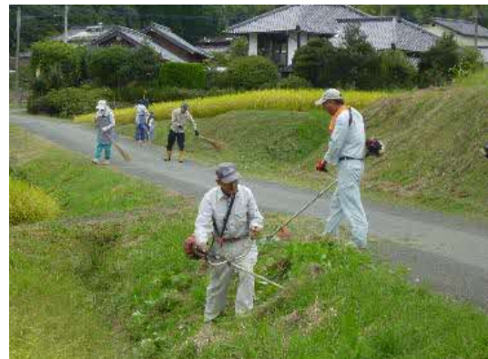
写真 農道法面の草刈の様子
