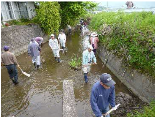
写真 水路の浚渫の様子
