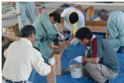
作業を行う鹿北町建築組合の皆さん
