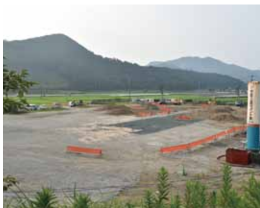
基礎工事が進む建設現場（8月19日）
