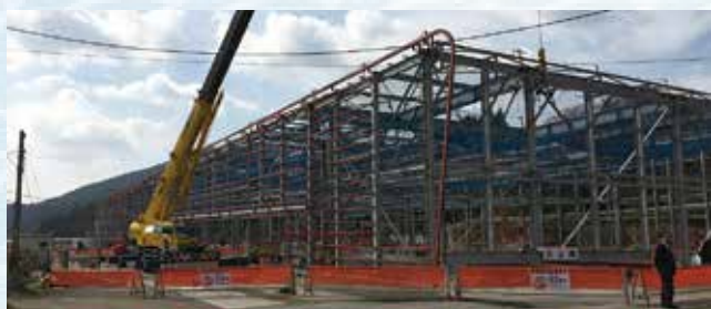
建設中の無菌養蚕プラント
