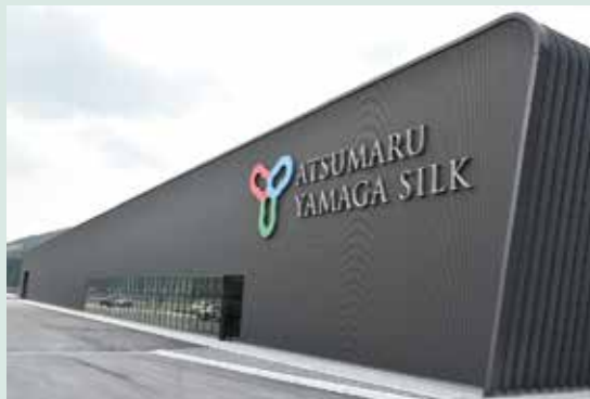
今年度本格稼働予定の工場
