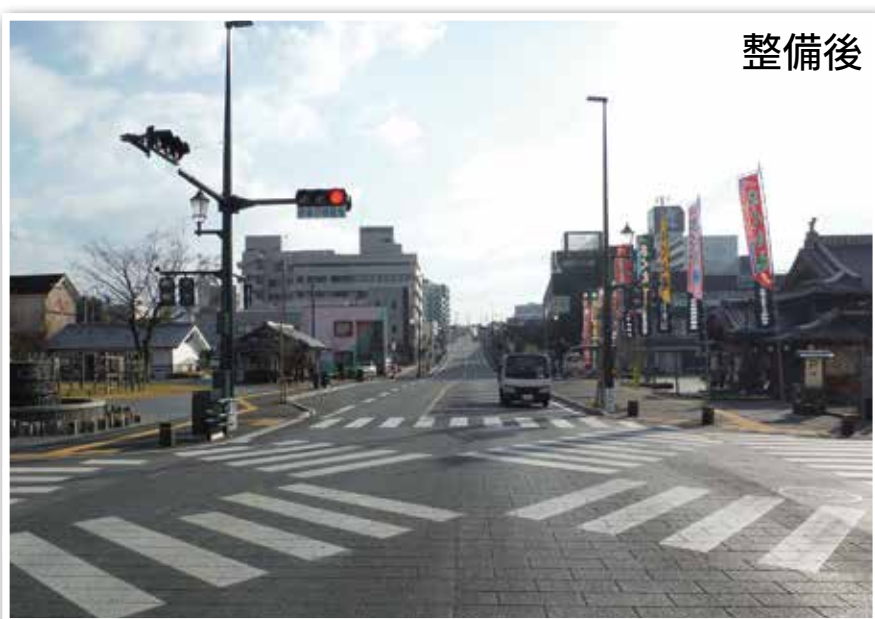
さくら湯前の交差点。電柱・電線が無くなり、すっきりしました
